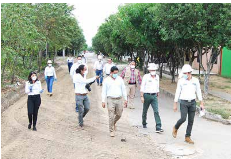
Varias vías en la ciudad, se encuentran en etapa de alistamiento para su pavimentación.
